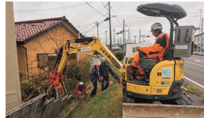
地震災害による危険ブロックの撤去
