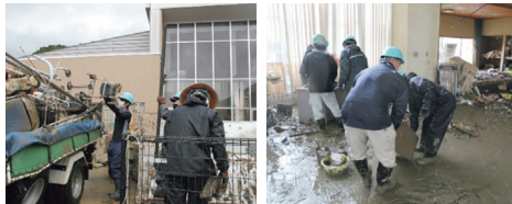
球磨村千寿園(高齢者福祉施設)で屋内被災物搬出や汚泥撤去
