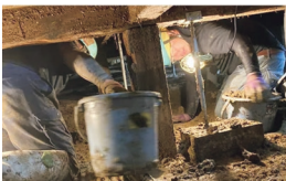
床下にもぐっての泥出し作業
