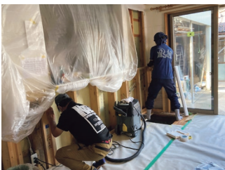
令和4年8月豪雨で床・壁はがしの様子
