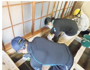
令和4年台風15号で床下に潜り消毒を行う
