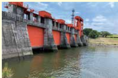
1924年完成の旧岩淵水門(赤水門)は、首都圏の治水を担った歴史的水門。現在は景観スポットで、ドラマのロケ地にもなっている
